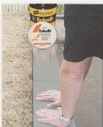
Oplechování rovnoměrně přitlačít
