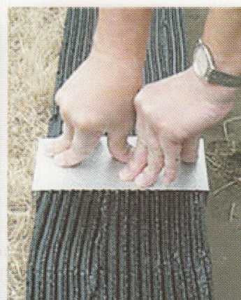
Zatlačení stykového plechu
